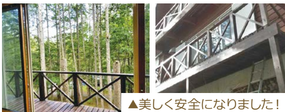
▲板を張り替え支柱を建てて…
