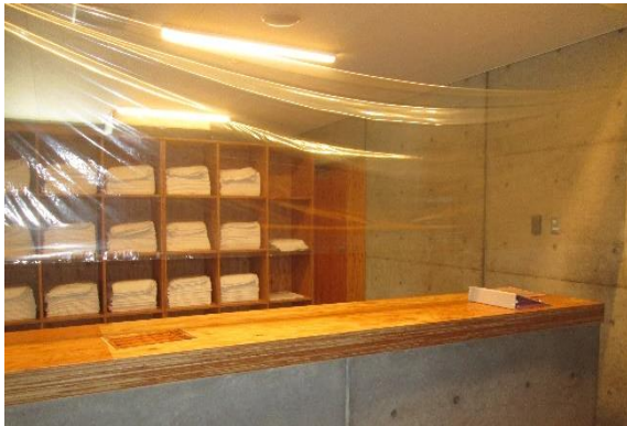
リネン室：飛沫防止用ビニールシートの設置
